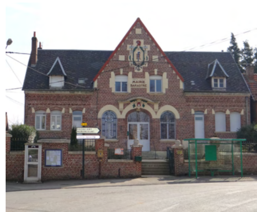
Fig. 13. Exemple d'architecture de la Reconstruction. Mairie de Barastre
