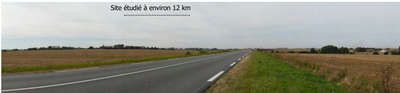
Fig. 23. Vue vers le sud-ouest depuis la RD930 à l'ouest de Boursies
