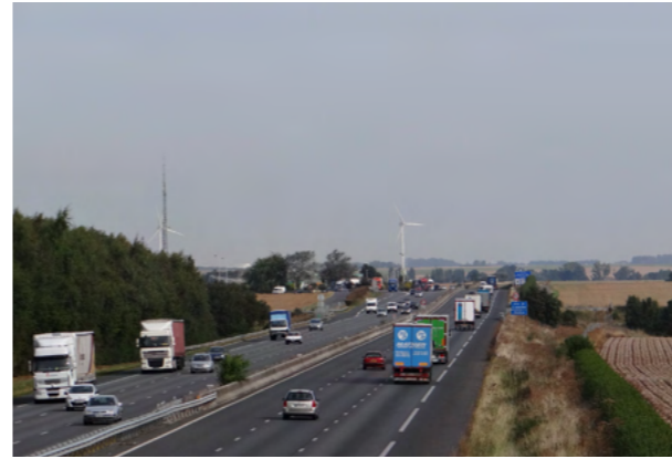
Fig. 25. Infrastructures : autoroute A1 et Parc éolien de Saint Léger
