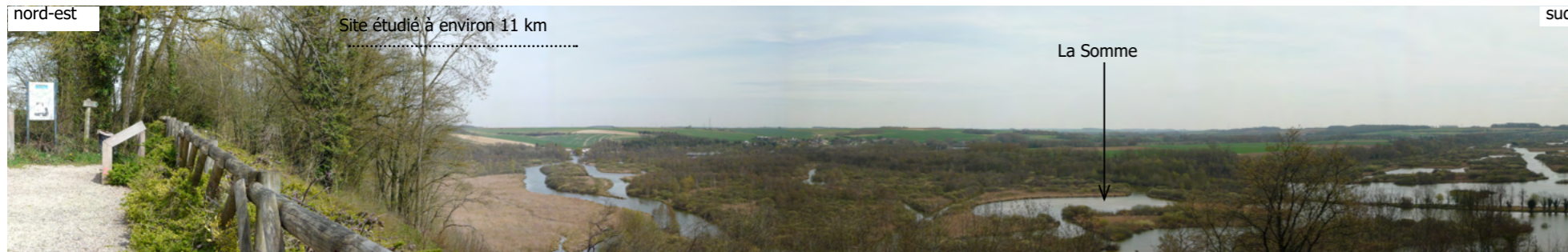
Fig. 52. Paysage des Boucles de la Haute-Somme (la Somme et ses étangs) vu depuis le belvédère de Vaux. Vue du nord-est vers le sud.
