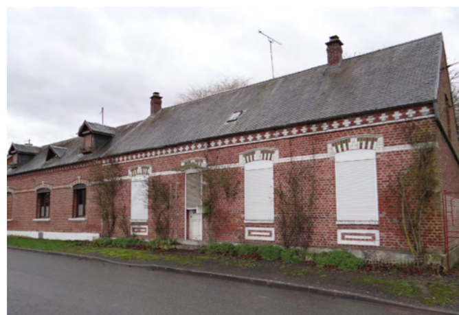
Fig. 56. Bâti en brique (Belloy-en-Santerre)
