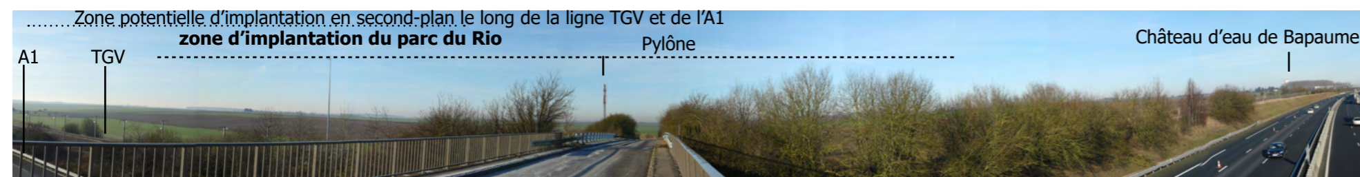
Fig. 62. Vue vers le site éolien le pont sur l'autoroute A1 (route entre Beaulencourt et Ligny-Thillois).
