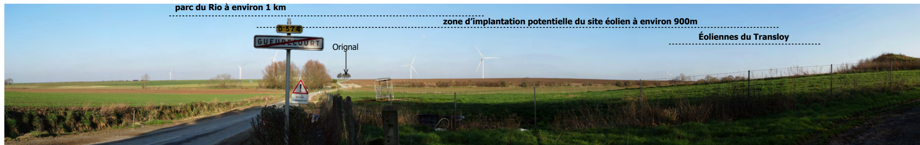
Fig. 74. Vue vers l'est depuis la sortie est de Gueudecourt sur la D574. (photo 2019)
