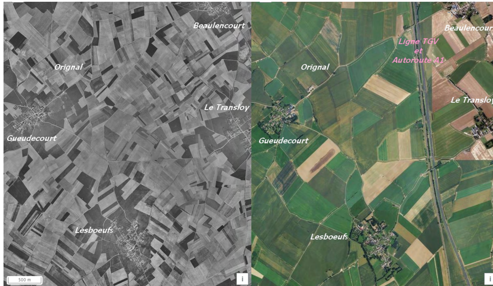
Fig. 59. Photo aérienne du site éolien, 1955/1965 et aujourd'hui. (Source «remonter le temps» de l'IGN)
